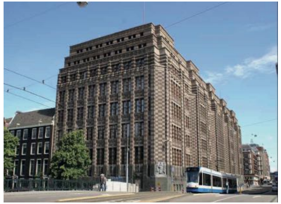
Het stadsarchief van Amsterdam, architect De Bazel
