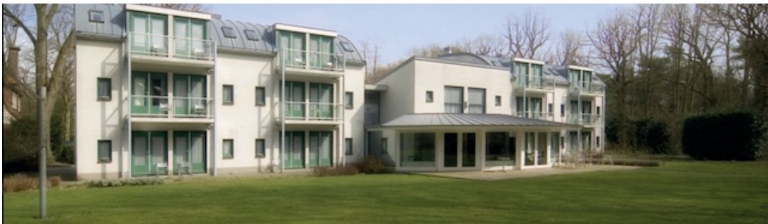
De uitbreiding van het NIAS, kamers voor de fellows en een vergaderzaal
